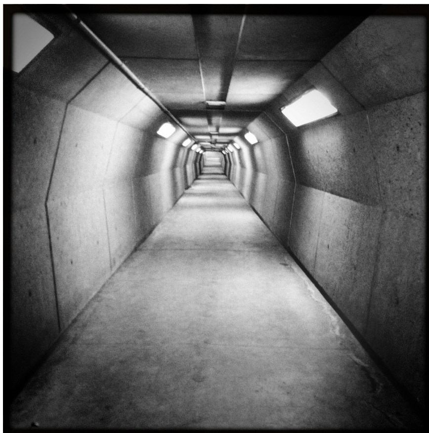
Иллюстрация 3. Подземный пешеходный переход в Монреале (Канада). Подобные тоннели могут быть особенно опасными для женщин, которые ими пользуются.
